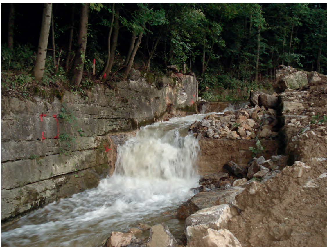
Rückbau des Stauwehrs 2007.
