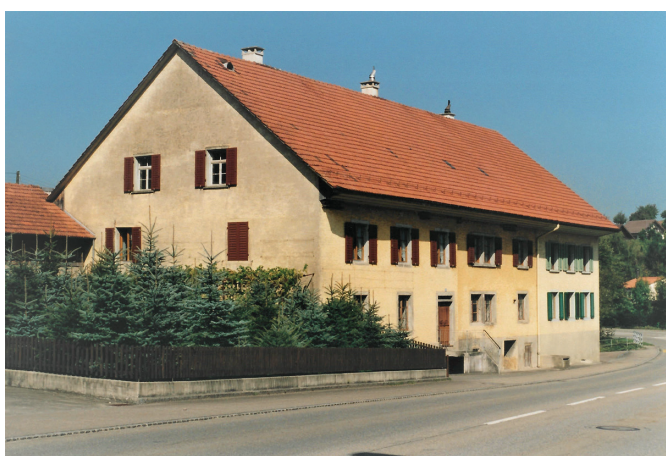
Die Mühle in Oberherznach. Der rechte Gebäudetrakt beherbergte die «Taverne zum Schwanen». (Foto von 2000)
